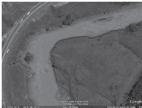
Figura 1: Local de Implantação da PCH Lavrinhas
