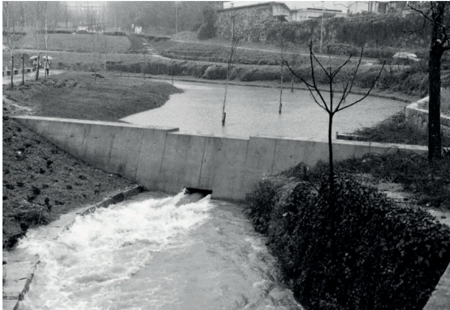
Figura 4 - Vista de uma bacia de retenção situada no município de Guimarães (Portugal).
